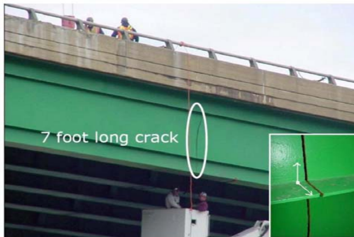
Fatigue Crack
